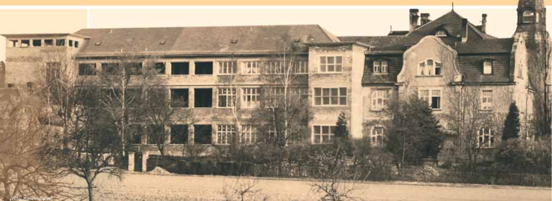
Das Marienhospital während der Bauzeit im Winter 1929/30. Architekt Dr. Max Melsheimer plante den Neubau links der alten Goebel'schen Villa.
